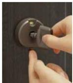
●防犯性に配慮し、脱着式のサムターン(補助錠側)を採用。ガラスを割り外部から手を差し込んでサムターンを回しても開錠できません。
