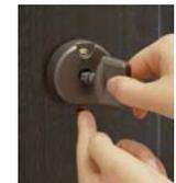
● 防犯性に配慮し、脱着式のサムターン(補助錠側)を採用。ガラスを割り外部から手を差し込んでサムターンを回しても開錠できません。
